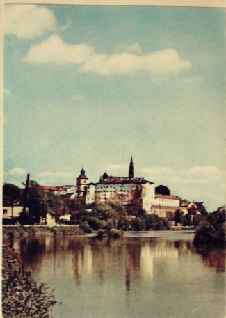
Widok ogólny na Bandomierz od strony Wisły.
